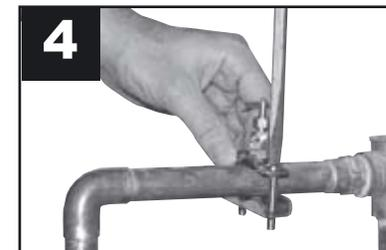
4 Перекройте подачу воды. Установите комплект для подсоединения шланга к водопроводу. Следуйте инструкции, входящий в комплект со шлангом. В комплект входят дополнительные аксессуары для большей гибкости подключения.
